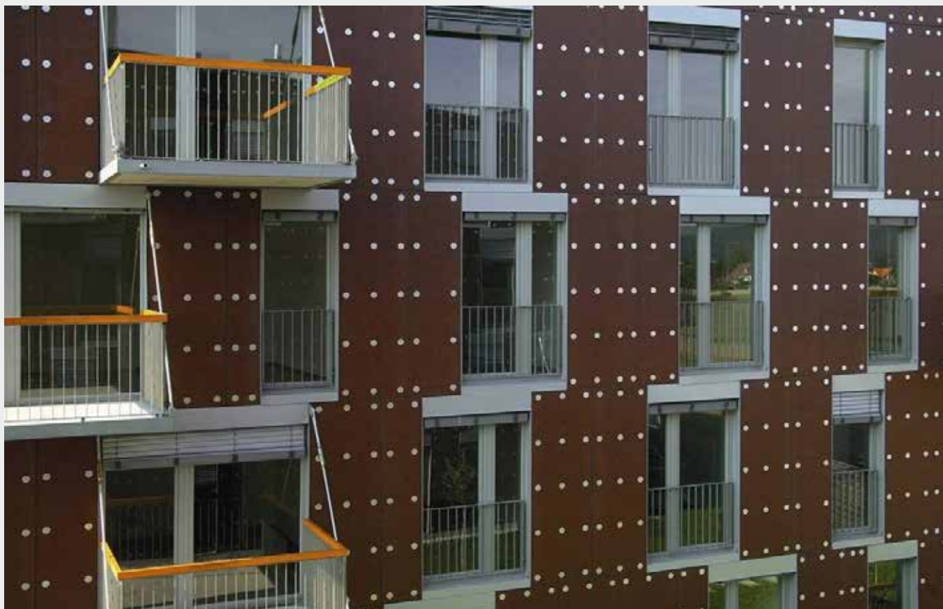
Fasadna obloga s poudarjenimi pritrditvenimi elementi in obešeni balkoni kot razpoznavni element soseske Polje I
